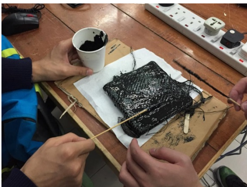
2 Wrapping the CFRP
